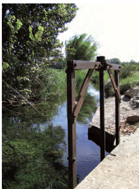
Prise d'eau du réseau gravitaire de Travaillan
